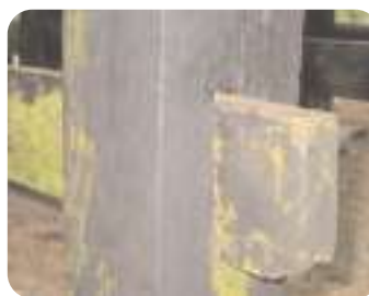
Pengikat kayu menyambung pelbagai bahagian rumah tanpa menggunakan paku atau skru Wooden fasteners join the various parts of the house together instead of nails or screws
