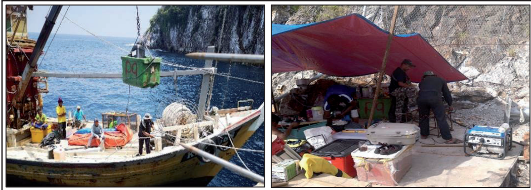
Rajah 3: Kerja-kerja mengangkut dan pemungghahan bahan binaan dari kapal
