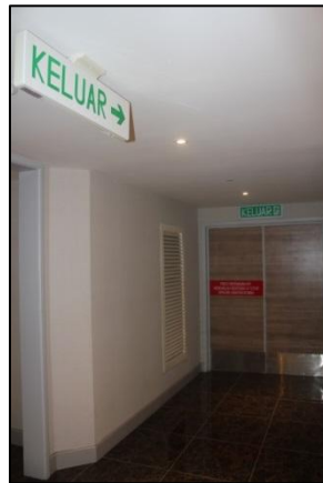
Foto 10 : Bagi pintu keluar yang terselindung, tanda 'KELUAR' dengan anak panah menunjukkan arah perjalanan menuju ke pintu tersebut.
