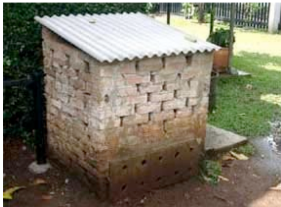
Foto 2: Kaedah Petak Cetek atau Bata
