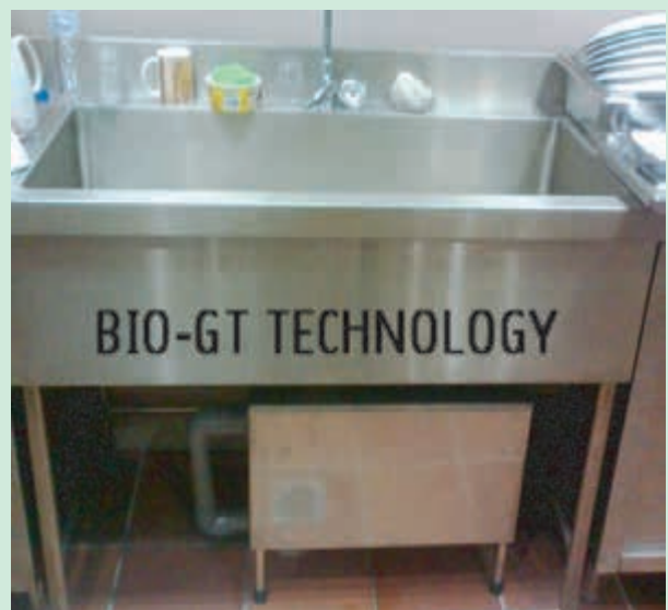
Alat perangkap minyak dan lemak yang digunakan di premis perniagaan
