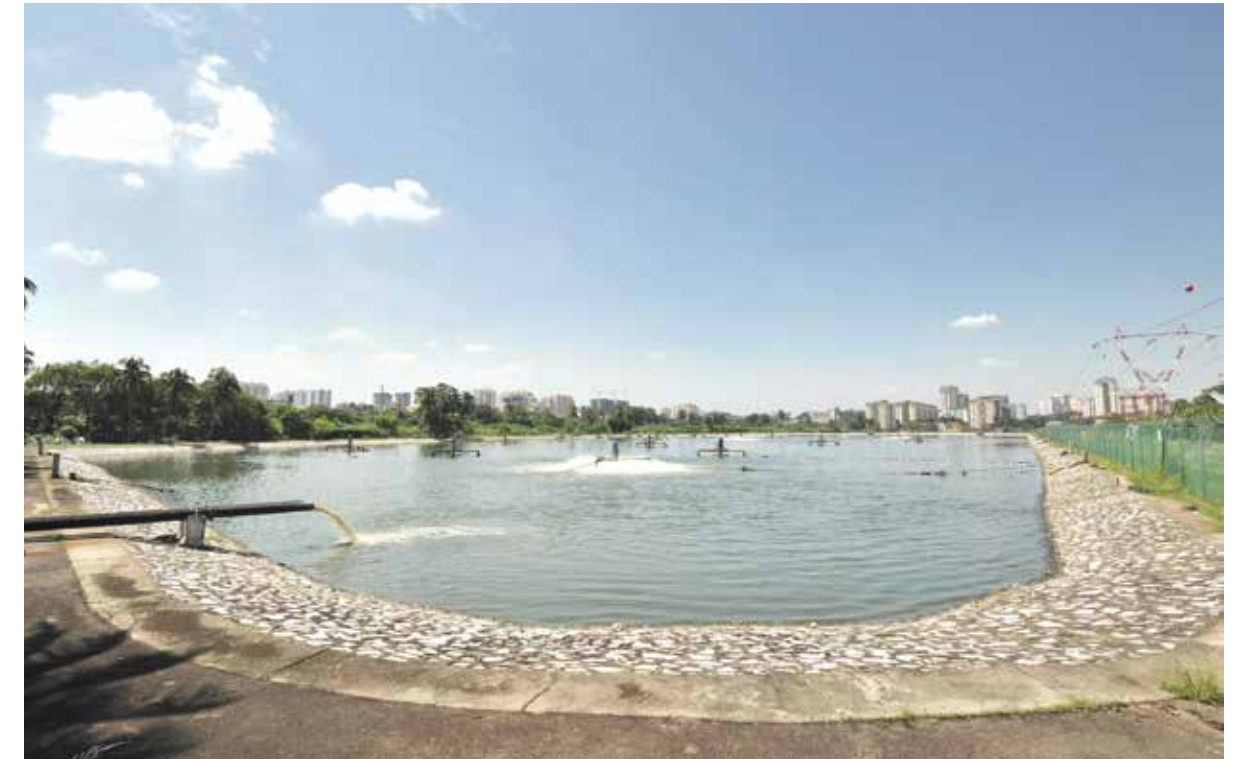
Kolam oksidasi tipikal yang seringkali dapat dilihat di kawasan-kawasan perumahan, yang mana satu kaedah popular untuk rawatan pembetungan bagi komuniti kecil.
