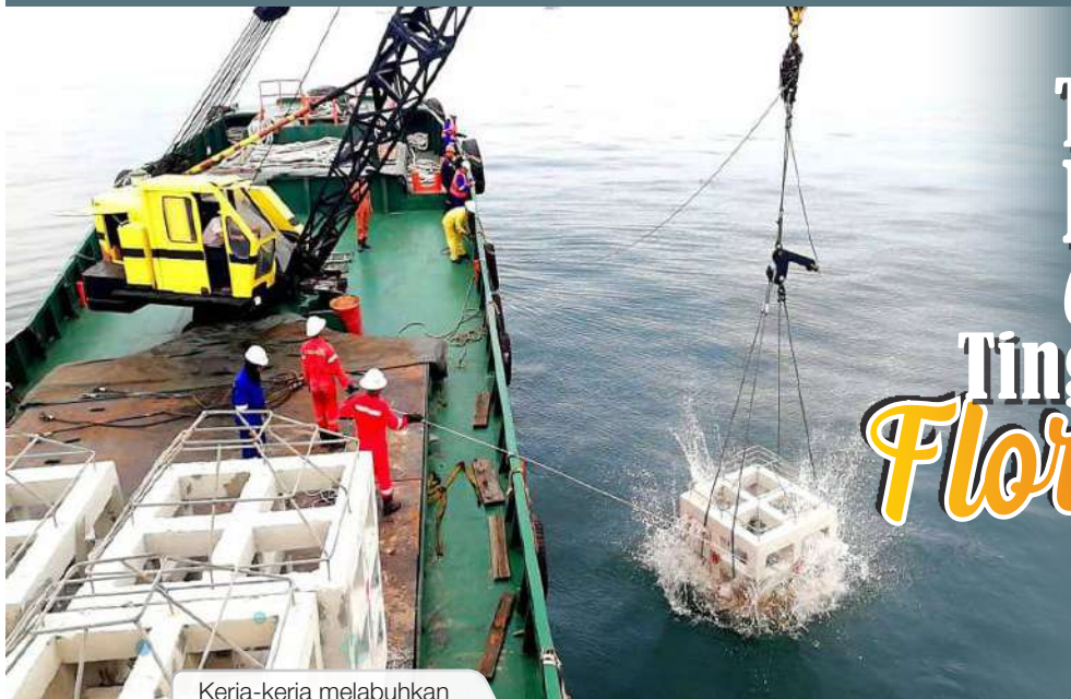
Kerja-kerja melabuhkan tukun tiruan.
