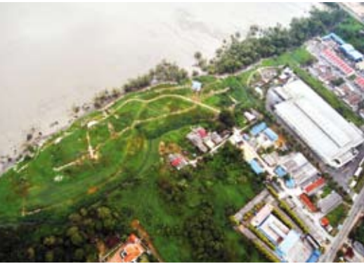
Tapak Pelupusan Rimba Terjun, Johor
