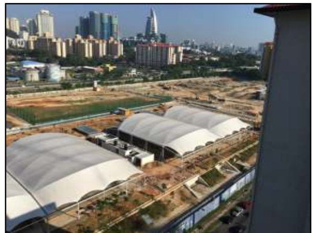
Pemasangan lengkap bumbung 'tensile' gelanggang futsal
