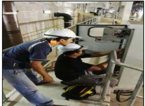
Penyambungan kabel bagi pam Return Activated Sludge (RAS)
