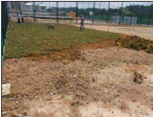
Pemasangan rumput Padang Bola Sepak
