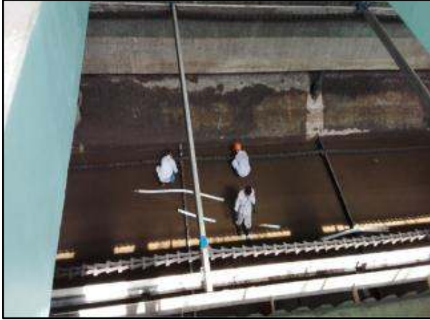
Kerja penyelenggaraan 'Scrapper' di 'Clarifier'
