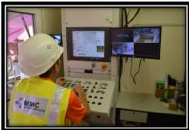
CCTV Bagi Kerja jacking
