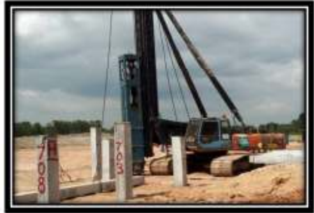
Kerja-Kerja Penanaman RC Square Pile
