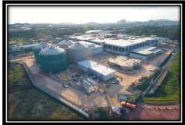
Pandangan Sisi (Pembinaan CSTP)
