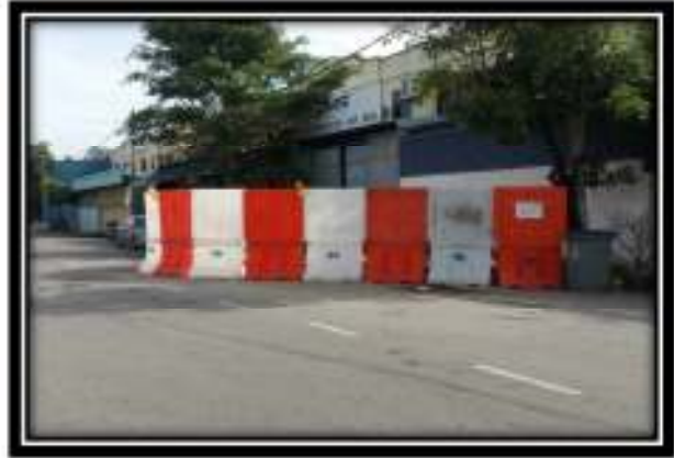
Pembinaan Jacking Pit
