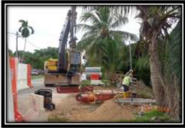
Pembinaan Jacking Pit
