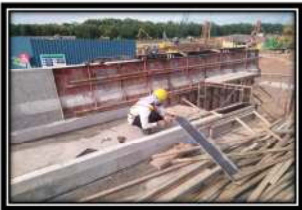
Kerja-Kerja Pemasangan Formwork
