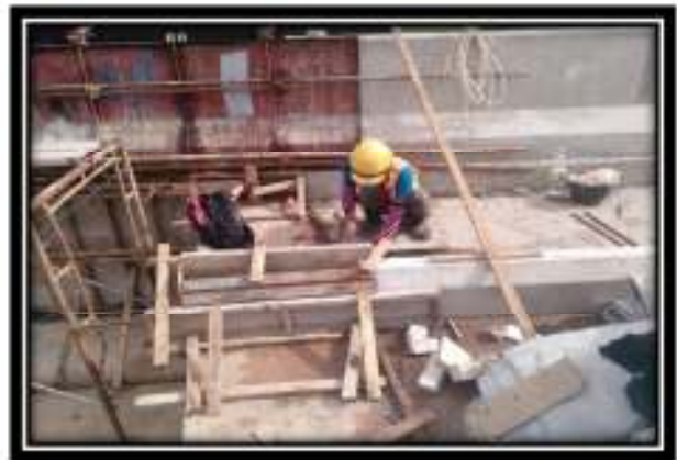
Kerja-Kerja Pemasangan Formwork
