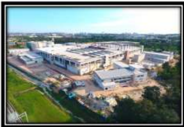
Pandangan Sisi (Pembinaan CSTP)
