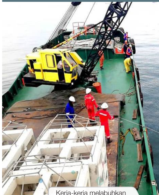
Kerja-kerja melabuhkan tukun tiruan.
