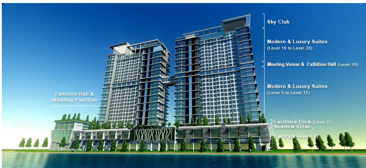
Projek pembangunan Emporium Residence Service Aptment di Kuantan Waterfront City oleh pemaju Ideal Heights Development Sdn. Bhd.
