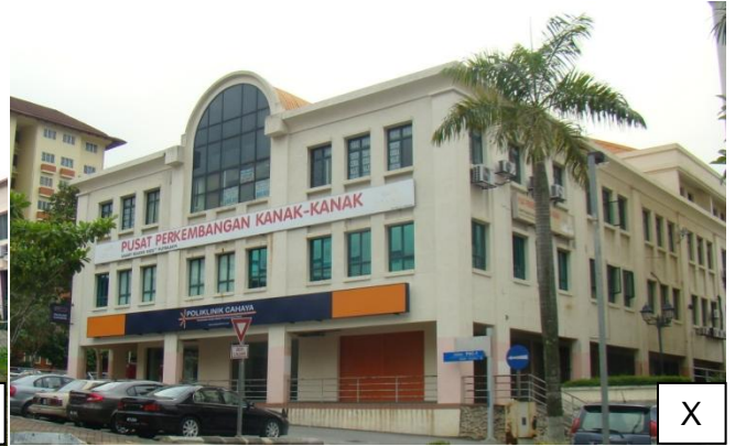
Contoh Tadika di lot perniagaan yang tidak menyediakan tangga kecemasan (Putrajaya, 14 Julai 2011).
