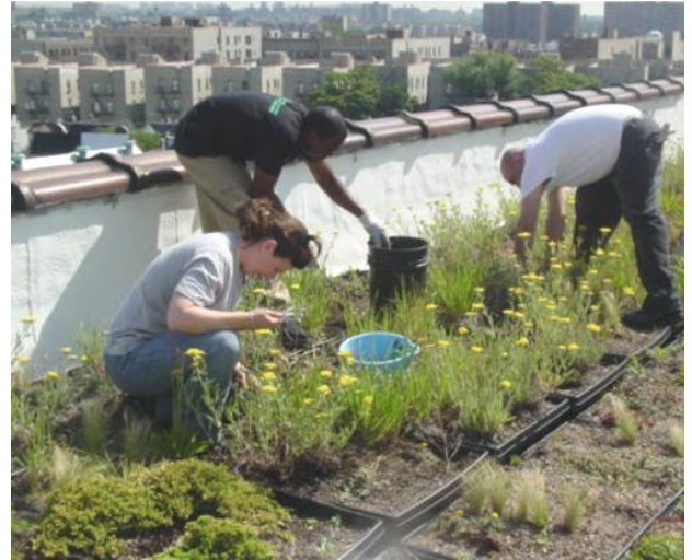
Foto 16: Contoh kerja-kerja penyelenggaraan di taman atas bumbung.
