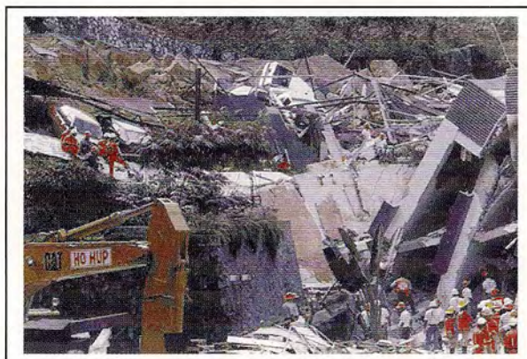
Bangunan Perumahan Bertingkat Di Tepi Lereng Bukit (Highland Tower) Yang Runtuh dan Terbalik Disebabkan Tanah Runtuh.
