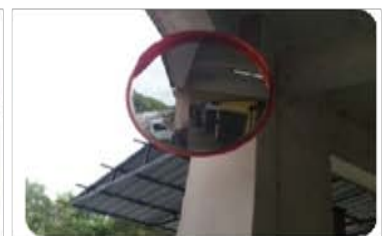
Cermin keselamatan Tmn. Pasir Putih, Pasir Gudang
